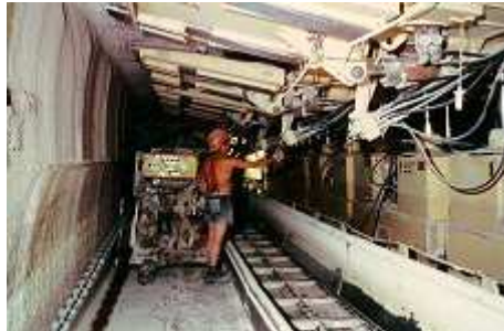
Soutènement marchant dans une taille de havage intégral
